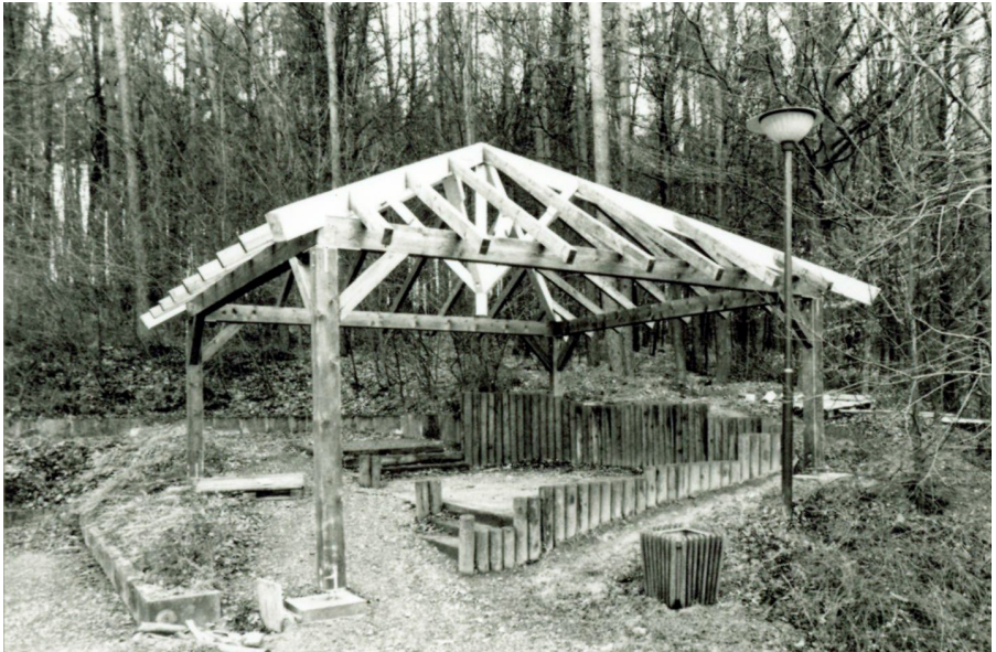
Pavillon im Bau
