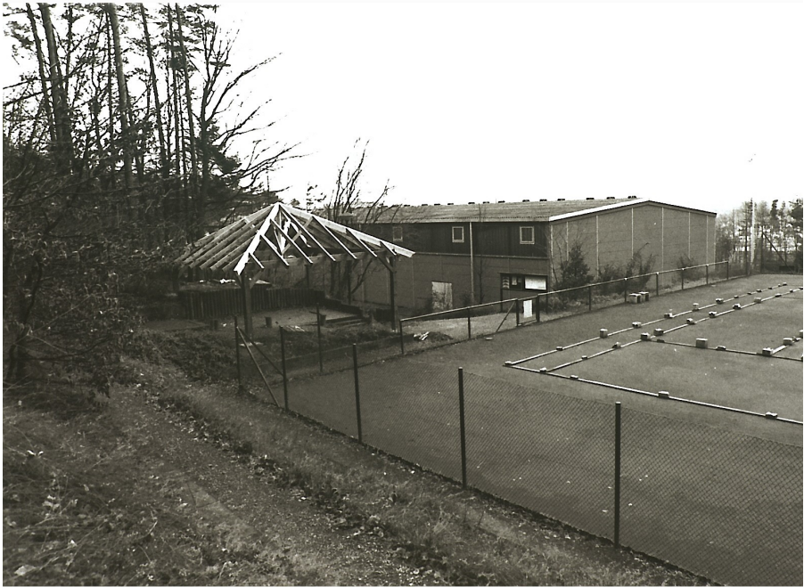
Pavillon im Bau
