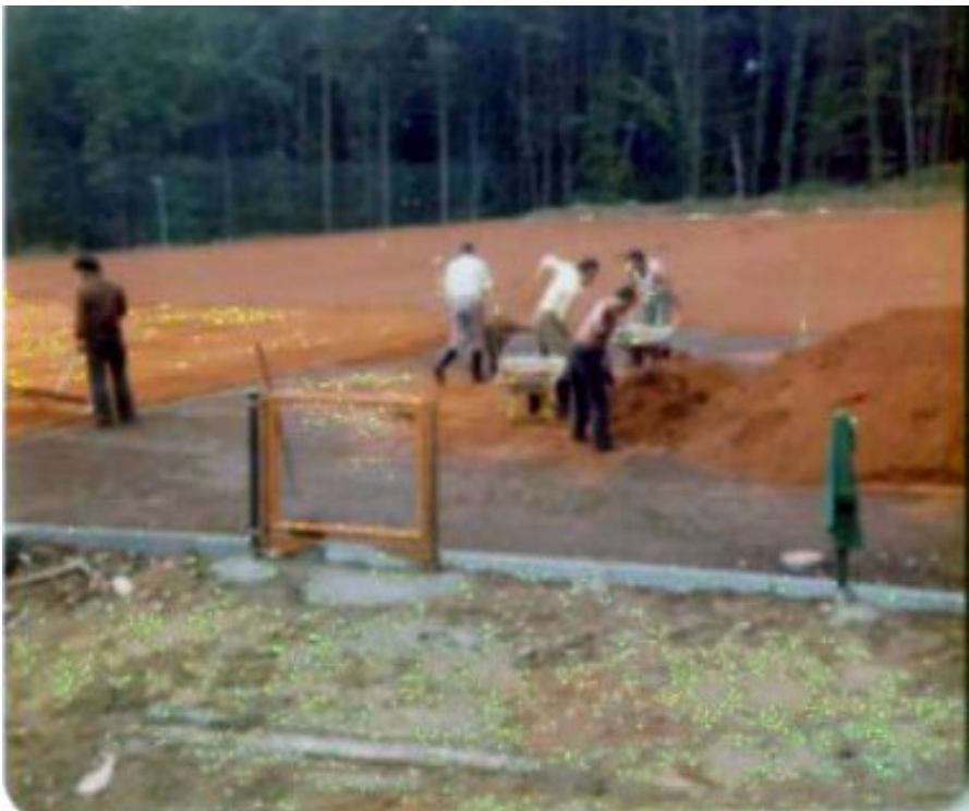
Bau der Platzanlage: Eigenleistungen immer und unentbehrlich
